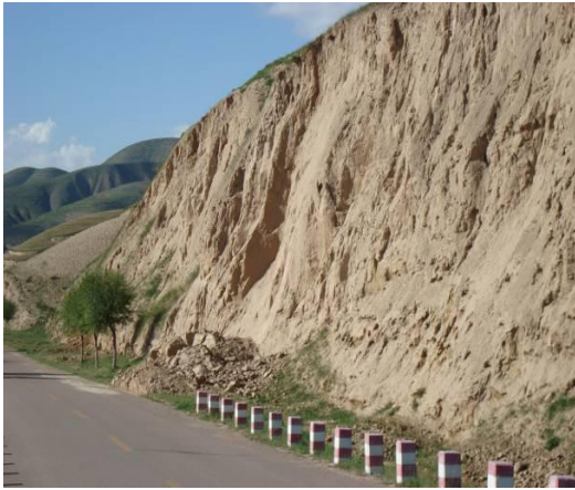
照片 3—6 西吉县公路边坡崩塌（镜向 300°） 照片 3—7 西吉县居民院内的崩塌（镜向 30°）
