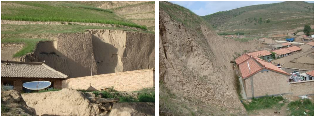
照片 4—8 西吉县村民开挖坡脚建房（镜向 10°、60°）
