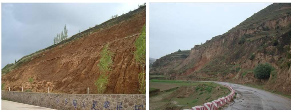
照片 4—9 西吉县公路边坡（镜向 30°、260°）
