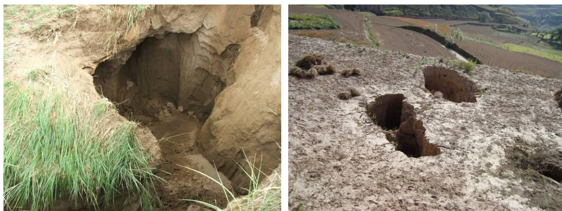
照片4—5 坡体上的落水洞（镜向30°、60°）
