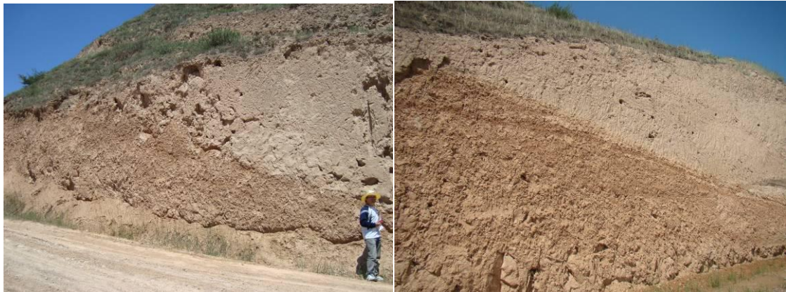
a 马建乡道路边坡出露地层（镜向 330°） b 苏堡乡道路边坡出露地层（（镜向 300°）
